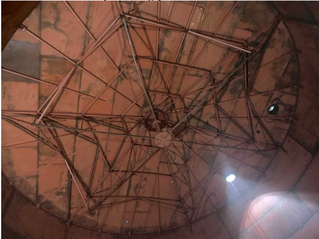
Mynd 1. Þak geymis.
